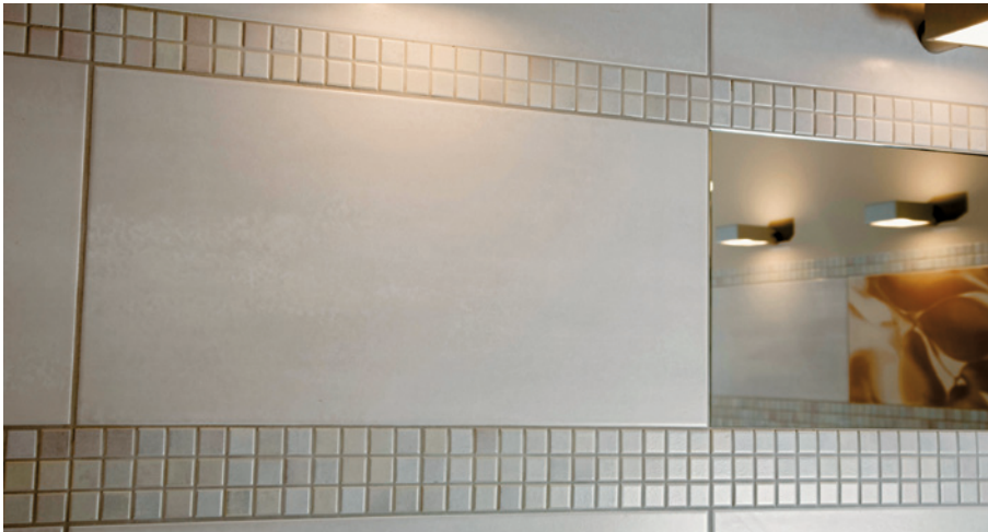
Abb. 6.10: Detailausführung des in die Fliesen eingelassenen Dekorbandes (Quelle: Deutsche Steinzeug Cremer & Breuer AG, Alfter-Witterschlick)
