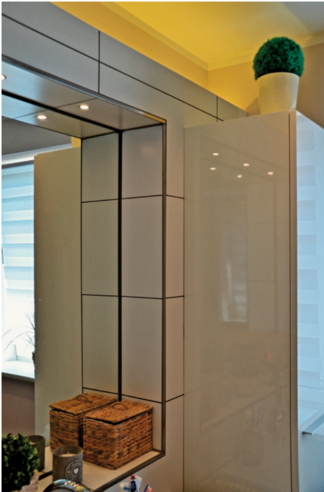
Abb. 4.13: Indirekte Raumbeleuchtung, die in die Vorwandschale integriert ist.
