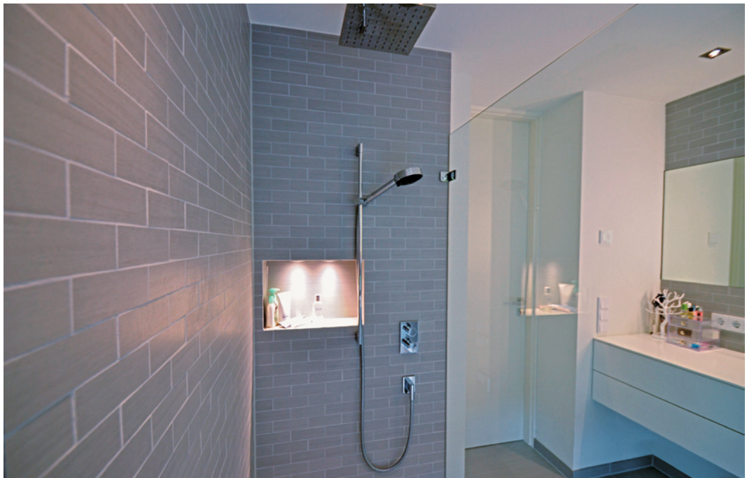
Abb. 3.15: Die Dusche und die Wandfläche oberhalb des Waschtischs sind vollflächig mit Riemchenfliesen versehen.
