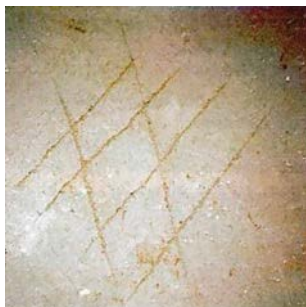
Abb. 3.1: Manuelle Ritzprüfung (Quelle: MAPEI GmbH, Großostheim)
