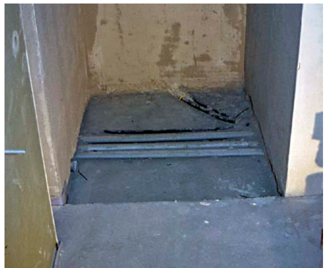
Abb. 9.2: Versorgungsleitungen erschweren die Abdichtung unter der Dusche (Quelle: Sopro Bauchemie GmbH, Wiesbaden, www.sopro.com )
