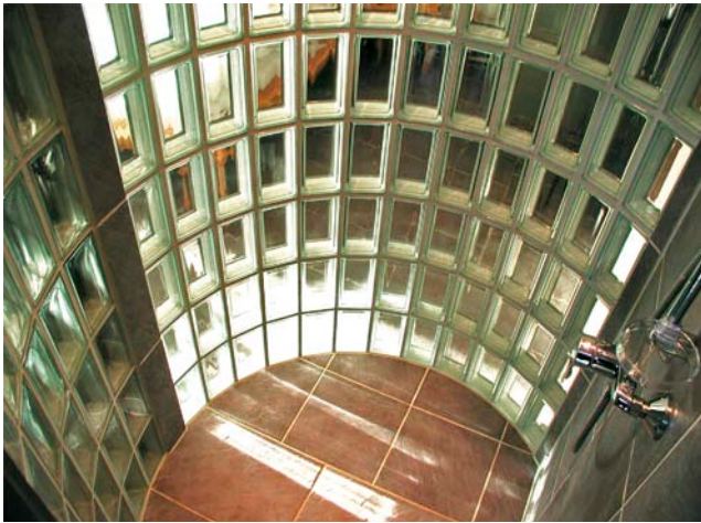
Abb. 8.13: Mit Glassteinen lassen sich auch gebogene Wandformen realisieren. (Quelle: Wünst & Partner, Singen)
