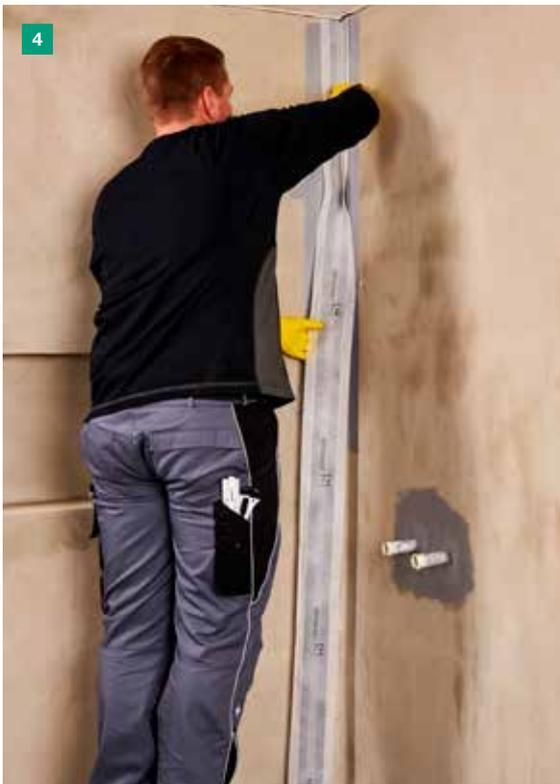
**4** Als nächstes folgen die aufgehenden Ecken in der Dusche. strasser DICHT DA-P wurde hier mittels „Mäuschen“ vorgelegt und danach das bereits im Vorfeld passend zugeschnittene Abdichtband (hier strasser DICHT FDB) eingelegt und ausgerichtet. Es ist beim Andrücken darauf zu achten,
