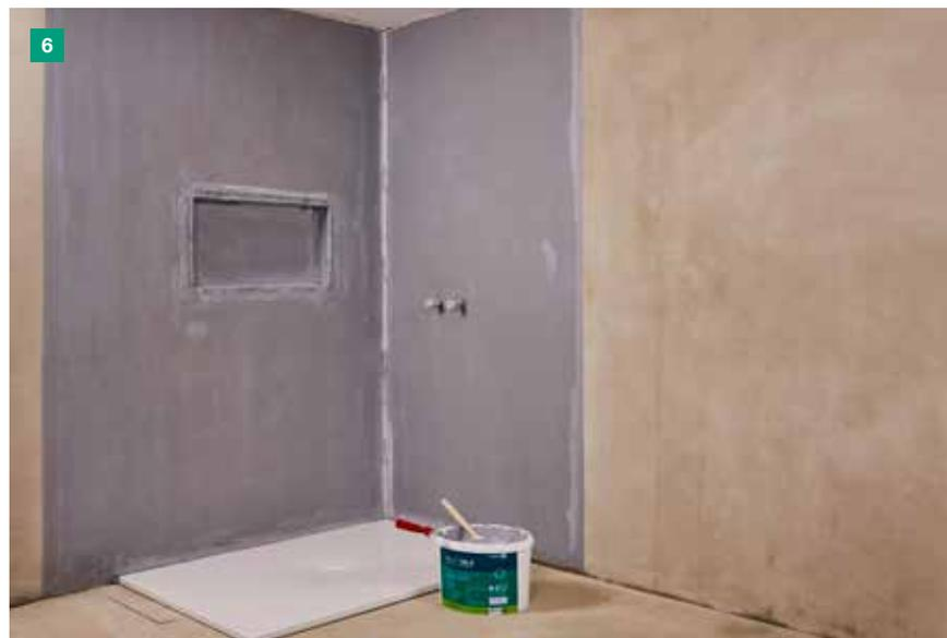
dass das Band satt in der Abdichtungsschicht liegt und sich hinter dem Band keine Luftblasen bilden.
